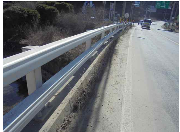
난간 및 연석 전경
